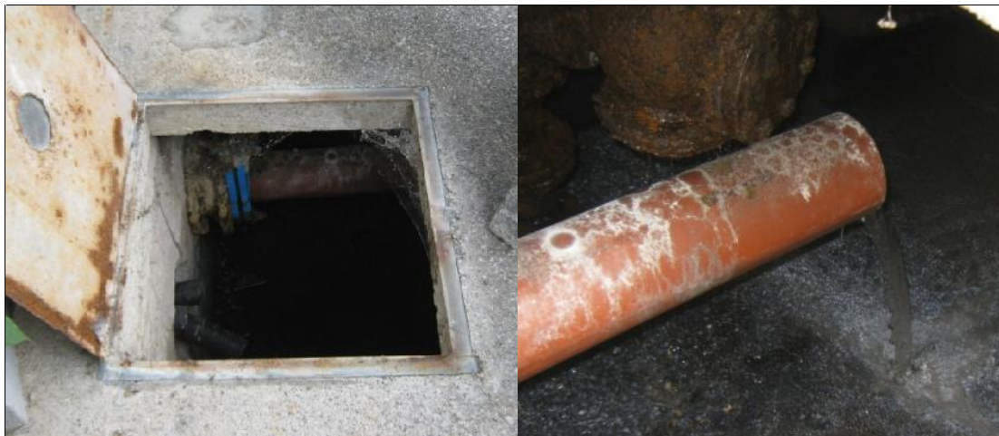
Abb. 7: Wasserauslauf vor dem Friedensstollen
