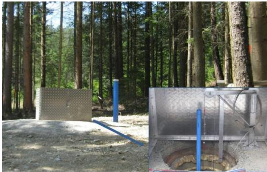
Abb. 5: Schachtkontrollstelle „Neuer Wetterschacht“
